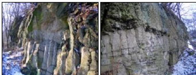
Pohled na část Hlavního masívu
